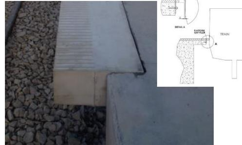
Figura 44. Rubber Gap Filler (fuente Acosta Ingenieros)
